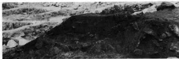
RE04竪穴状遺構南北断面
