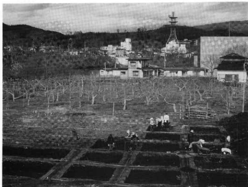
西方向より粗掘風景
