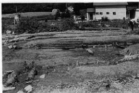
1号池土留め (W→)
