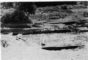
1号池土留め (E→)
