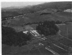
調査区遠景 (E→)
