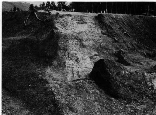
土橋完形状況 西から
