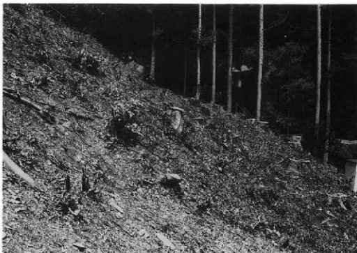
東側三段目平場 現状(Ⅱ区)南から
