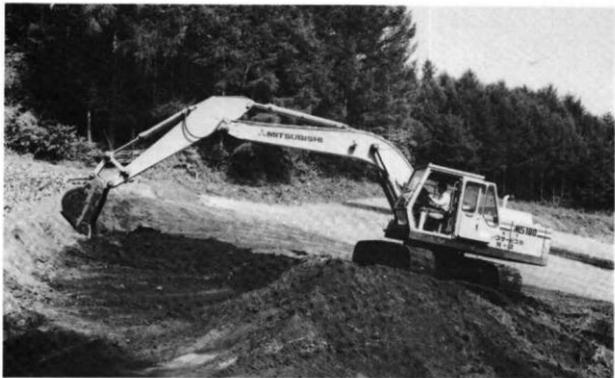
A 重機による粗掘り作業中
