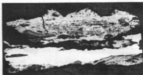
図4 棟部錆片マクロ組織
