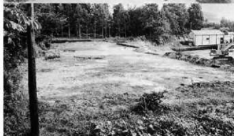
3. A地区全景(北から)
