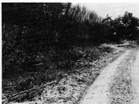
館北西堀・土塁(北東から)
