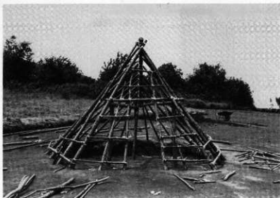
1. 樺木組立完了(正面)
