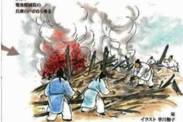
不動倉11棟が火災で焼失
