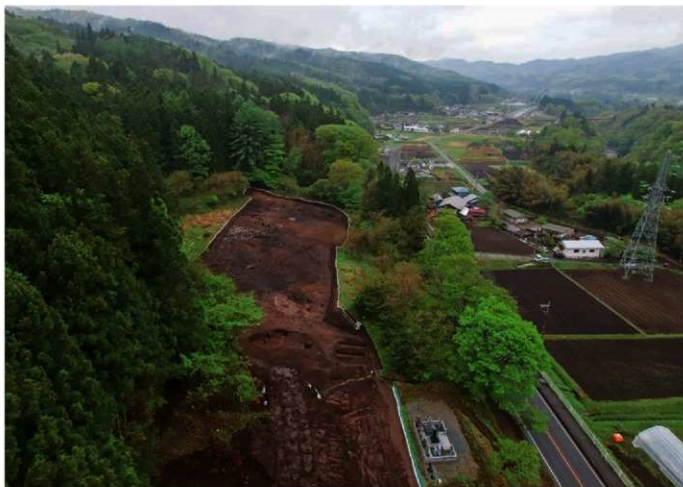
1 1面全景(北東から)
