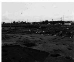
F地点 作業風景 (1)
