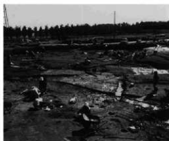
F地点 作業風景 (2)
