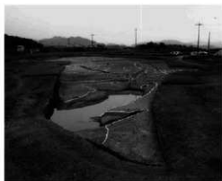
E地点 全景 (2)
