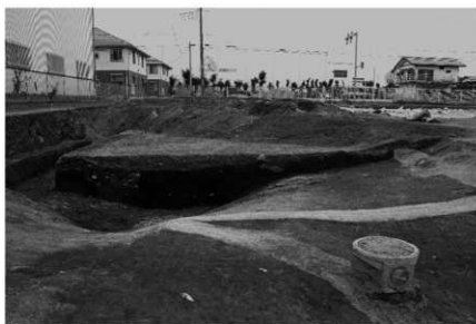
周堀P断面 北から
