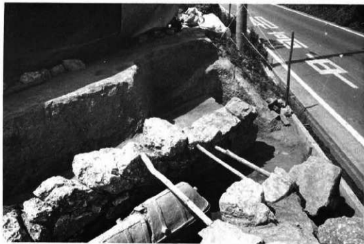
1. 奥壁部の型方(南東より)
