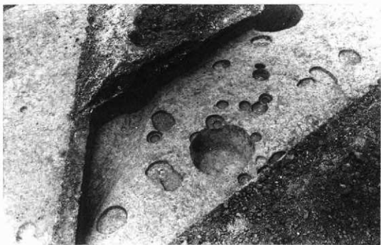
2. GTの遺構 (南から)
