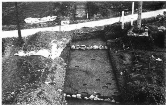
1. 塔基礎 (西から)
