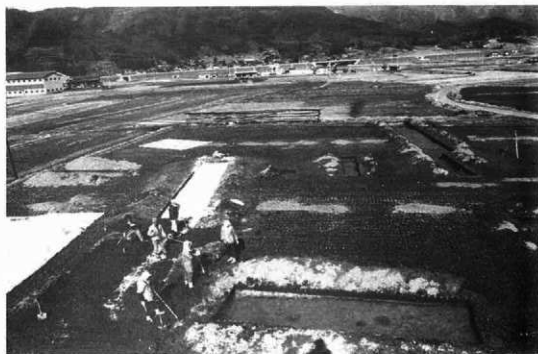
2. 埋め戻し風景 (南から)
