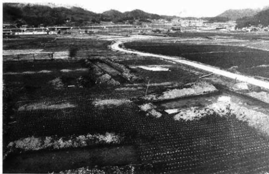
1. 講堂，回廊取り付け部全景（南から）
