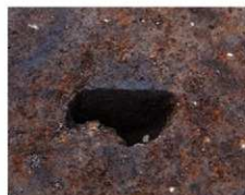
8 19号ビット断面 南から
