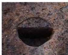
10 20号ビット断面 南から
