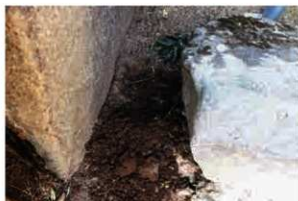
3-7 支保工掘削部分土層 (西より)
