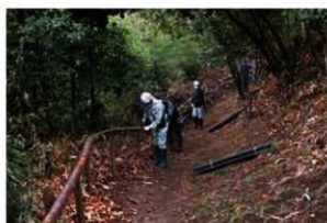
2-8 既設柵再設置風景 (北より)
