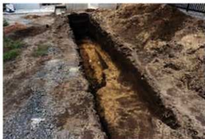
2-6 掘りこみ完掘状況 (北より)
