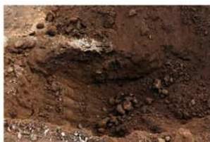
4-10 構造物撤去後土層 (西より)
