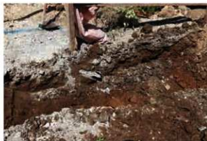
4-2 基礎部分掘削状況（北より）
