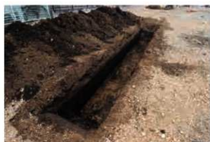
4-11 IT完掘状況 (北西より)
