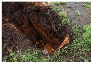
4-4 基礎掘削部分北壁（南より）
