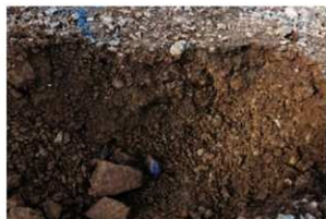
4-8 基礎部分掘削状況 (西より)
