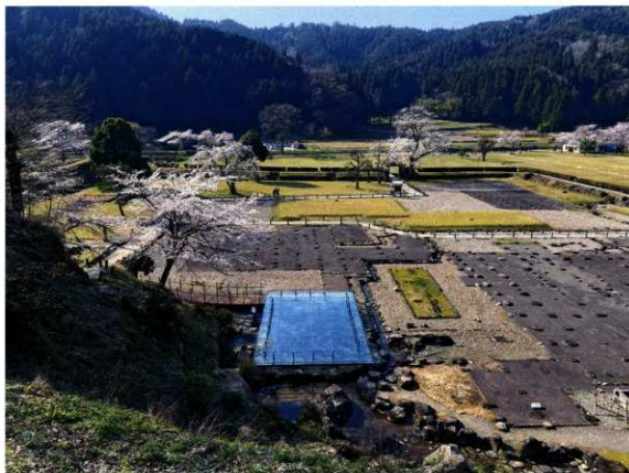
朝倉館跡回遊・鑑賞施設再整備工事 施工後（東から）
