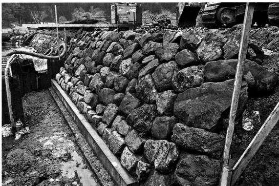
石積工の施工状況（南東より）
