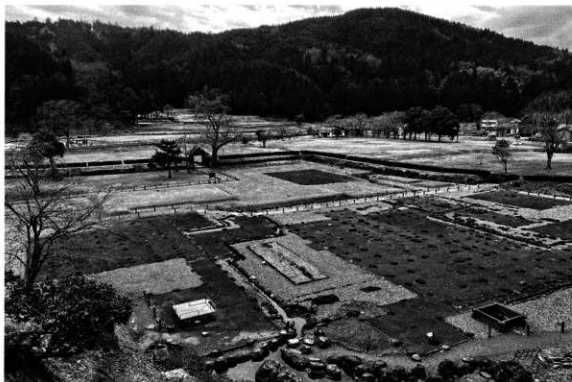
施工前（南東より）
