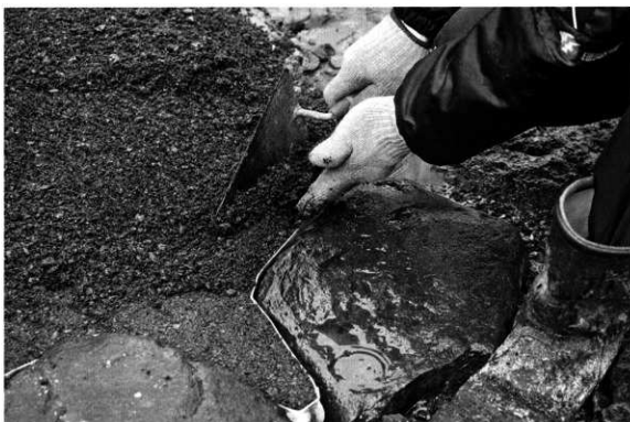
舗装と遺構石との縁切りの施工状況
