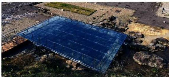
朝倉館跡回遊・鑑賞施設再整備工事 施工後（南から）
