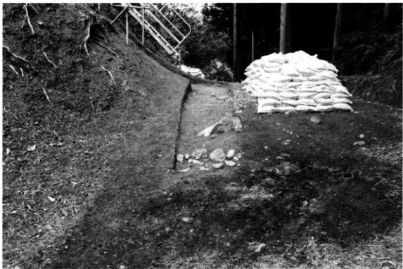
対象地③第5トレンチ石積みを伴う低土塁（南より）
