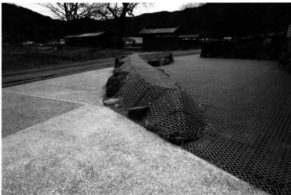
土壘跡展示工（西より）
