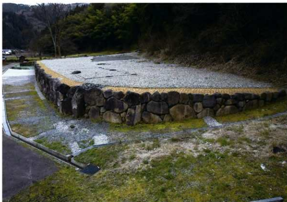
西山光照寺跡整備工事対象地全景（北より）
