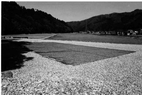
建物跡展示工（南より）
