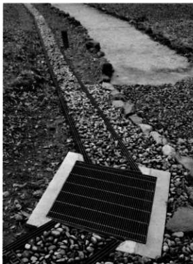
排水工 集水樹2B（西より）
