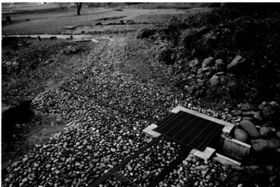
排水工 集水樹2A（北より）
