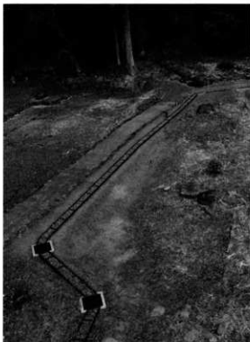
排水工 全景（東より）
