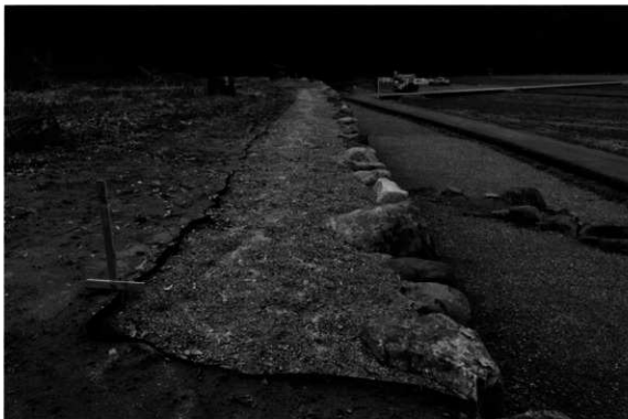
石垣復元工（天端仕上げ）
