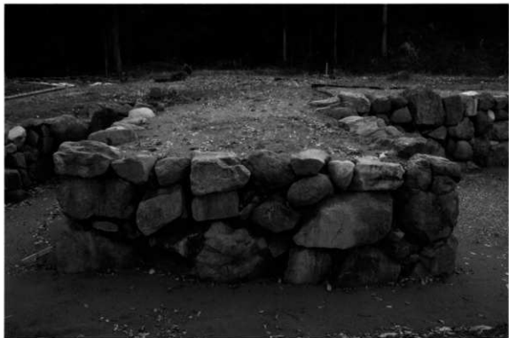
石垣復元工（突出部）
