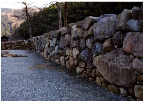
西山光照寺跡整備工事（北より）
