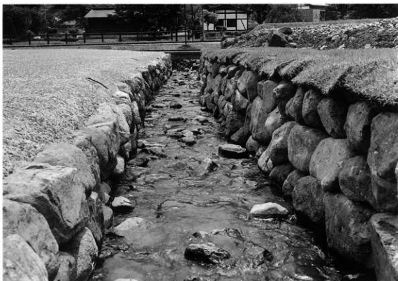
護岸工(西より)
