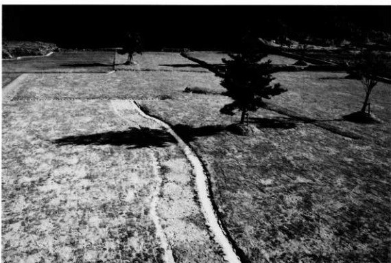
権殿地区復旧整備工 全景(西から)
