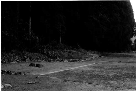
御所安養寺地区復旧整備工（北から）
