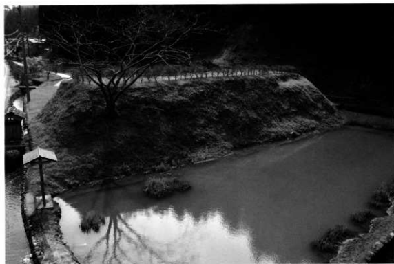
下城戸瀬復旧整備工 全景（北東から）
