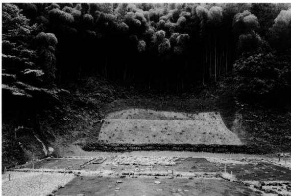
朝倉館山裾法面等復旧整備工全景（西から）
