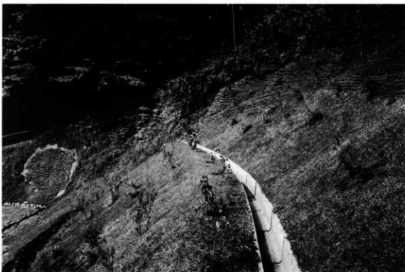
朝倉館山裾法面等復旧整備工（小段南から）
