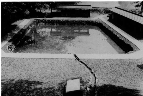
西山光照寺池復旧整備工（南西から）
