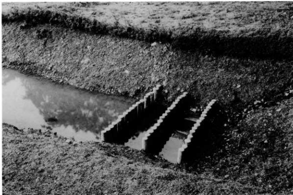
朝倉館北溪復旧整備工（南東から）
