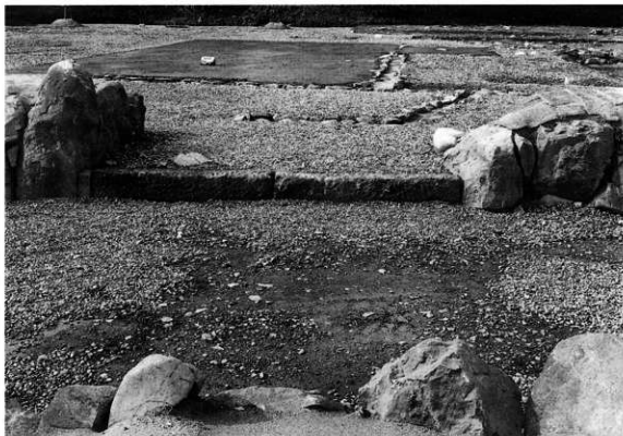
入口SI4750整備状況(東から)
