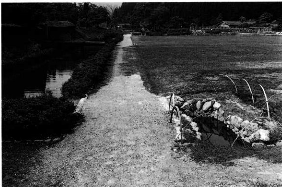
朝倉館北西コーナー園路整備工（北から）
