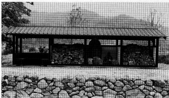
石仏覆屋整備工 (石仏展示収納棟) (西から)
