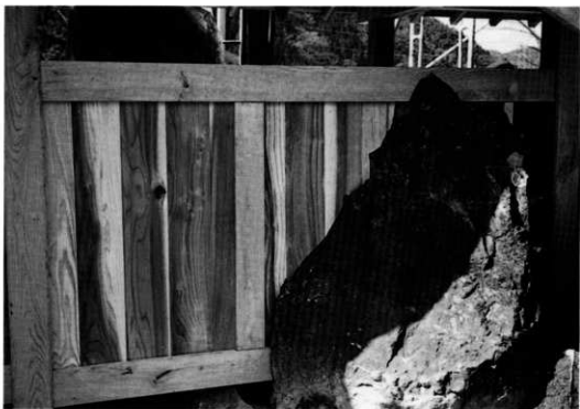
同 壁板のひかりつけ作業
