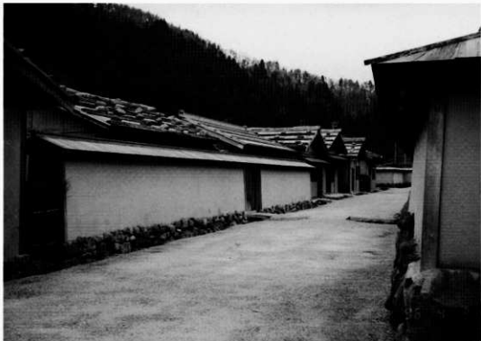
道路整備・南半部（北から）
