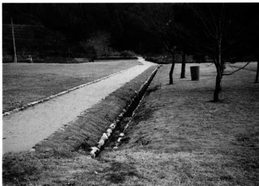
園路及び排水路 (西から)
