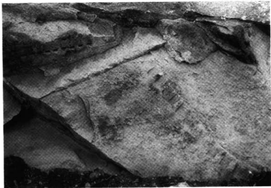
竜山石切場跡 KA-7地点 矢穴痕
