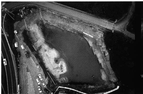
上空から見た松帆湊（実線が検出された岸壁のライン）
