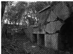
砲側庫及び砲座へ続く階段 (生石山第五砲台)
