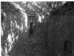
隧道出口部の外観
