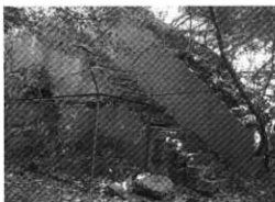
砲側庫（生石山第二砲台）
