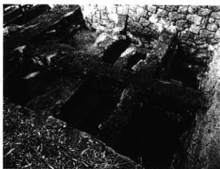
火薬庫跡床面の状況
