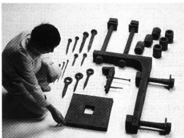
内部木遣部を結合している金具類
