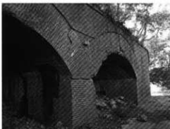
2連アーチ状の砲側庫(生石山第一砲台)
