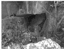
砲側庫と思われる施設（北東から）
