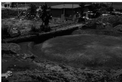
石神境古墳 墳丘南西半検出状況 [南東から]
