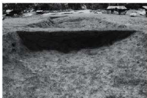
3号方形周溝墓D-D' 東溝土層断面（南より）
