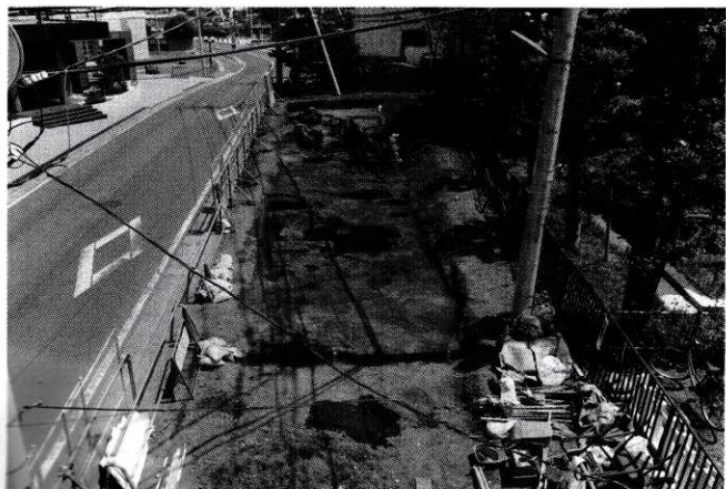
2 調査区東側全景 (西から)
