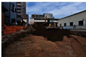
6 東側調査区埋め戻し（東から）
