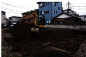
2 西側調査区表土掘削（北西から）
