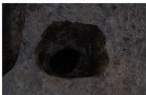
4 第17号ピット完掘(北から)
