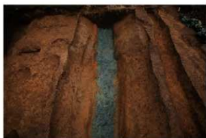
7 第1号溝状遺構完掘状況（西から）
