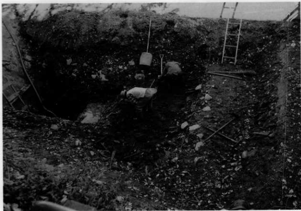
PL14 D-D' 断面附近 建築廢材出土狀況
