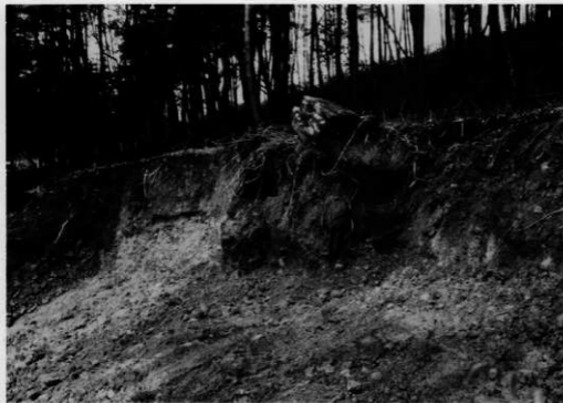
2. 開削状況（南より）
