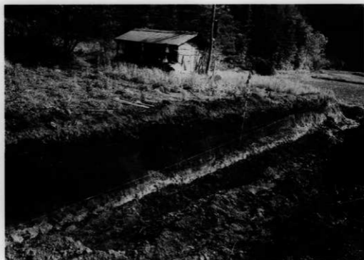
2. トレンチ状況
