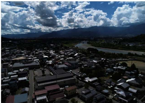
調査地遠景（北から）
