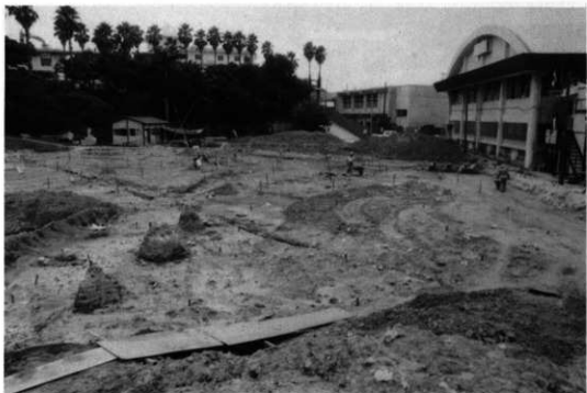
新築中の現場 トレンチの設定、北側より南側を望む
