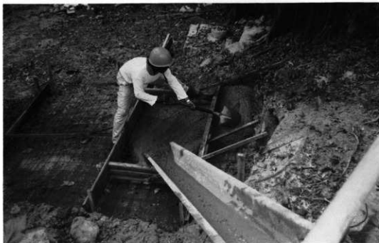
15 基礎工事（コンクリート流し込み）
