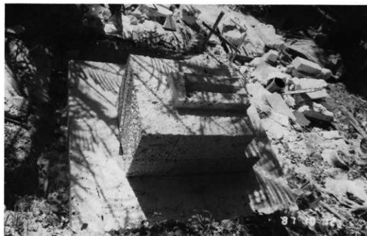
18 基壇の敷設完了
