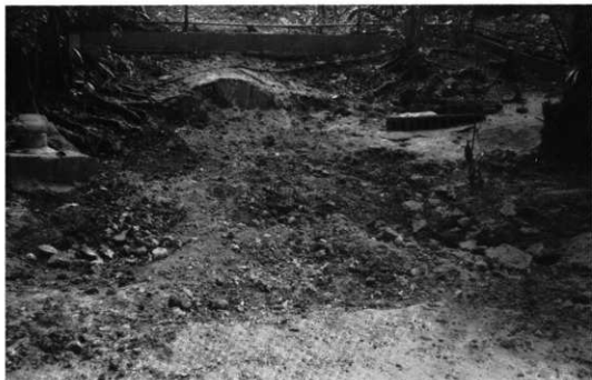
12 旧跡碑およびデイゴの解体（撤去）終了
