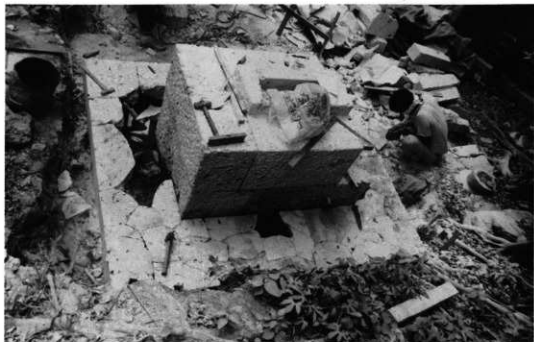
17 台座組積と基壇の敷設
