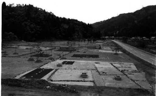
東 半 部 (南から)
