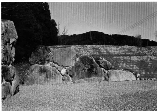
城戸口南面石垣 (南から)
