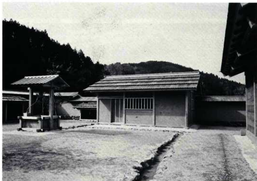
使用人小屋 (東南から)
