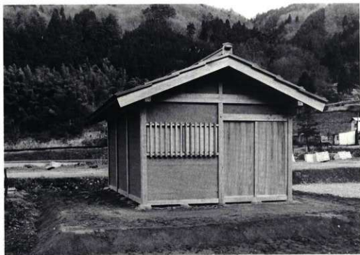
消火ポンプ小屋 (西から)
