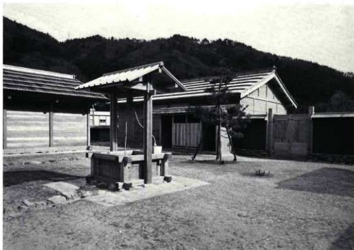
井戸・便所・櫓中門 (西北から)
