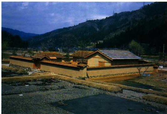
復原武家屋敷全景 西南から
