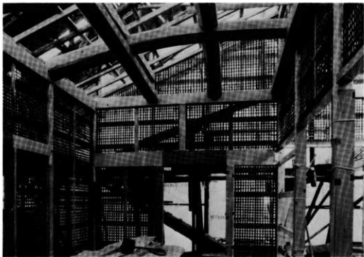
軸部及壁小舞 (土間部) 西から
