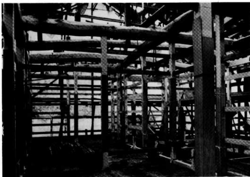
軸部 (南半) 東から
