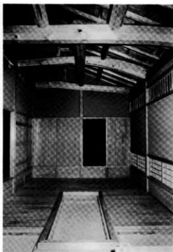
室内 (北半板間部) 東から
