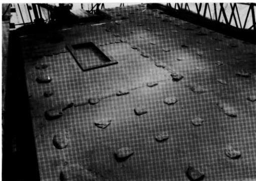
礎石据付状況 西北から
