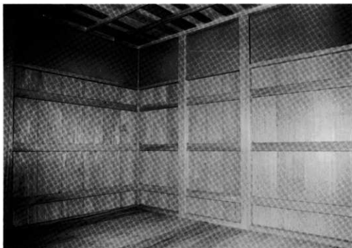
室内 (納戸) 西北から
