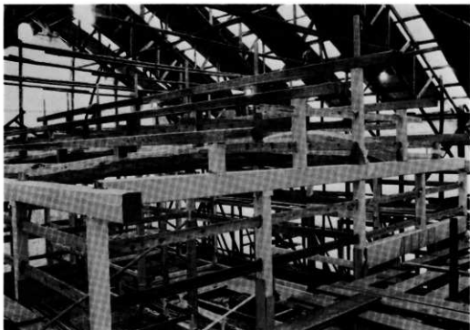
軸部及小屋組 東南から
